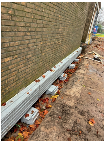
(2,3) Ondergrondse isolatie verlijmen
