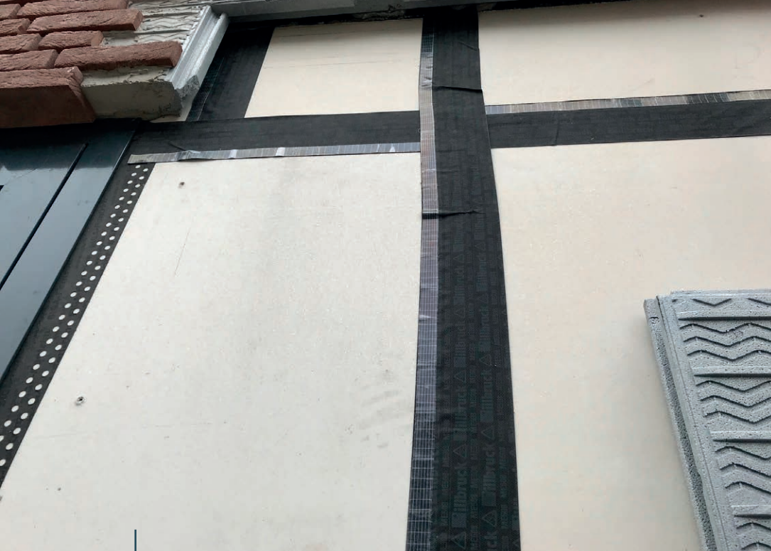
Colmatage des jointures
