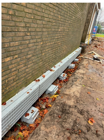
(2,3) Isolation souterraine par collage
