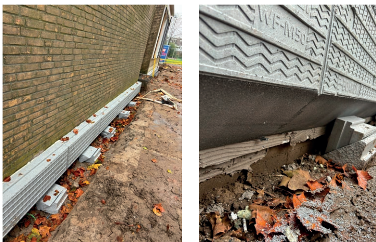
(2,3) Ondergrondse isolatie verlijmen
